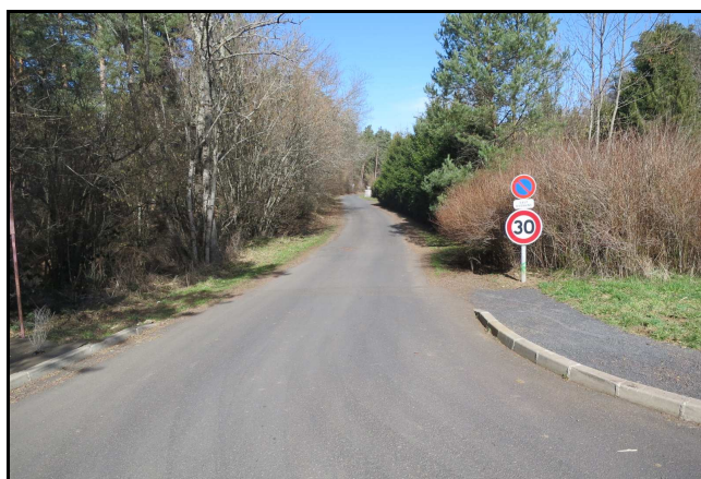
Zone 30 sans aménagement (la Cassière)
